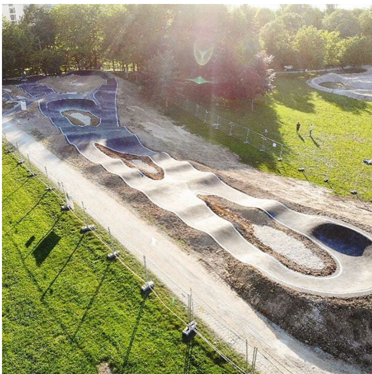
Parcours de Pumtrack de Reims, avant végétalisation.
